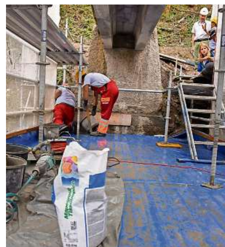
Schritt für Schritt: Für die Arbeiter gibt es noch viel zu tun.
