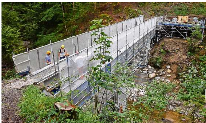
Vollkommen eingerüstet: Von der Hebeltobelbrücke ist momentan nicht viel zu sehen.
